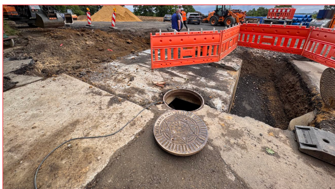
Construction d'un nouveau bassin d'eau
