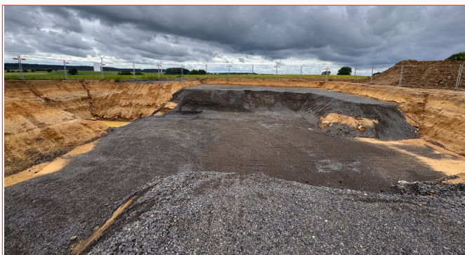
Construction d'un nouveau bassin d'eau
