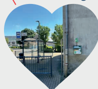
Salle sapeurs pompiers (extérieur) Hagen
