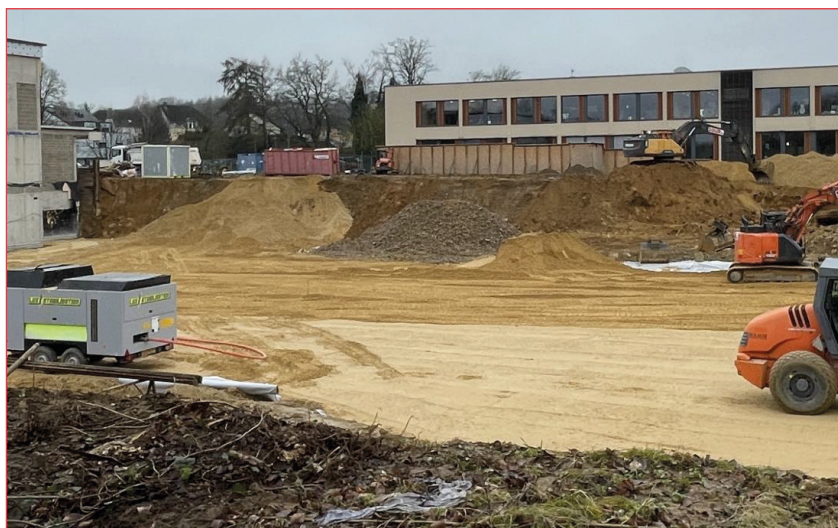
Construction hall sportif (phase 2)
