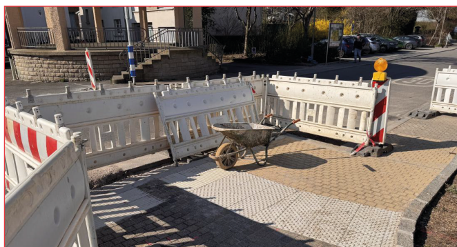
Aménagement passage piétons N6
