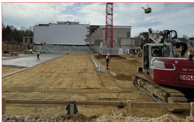
Construction hall sportif (phase 2)
