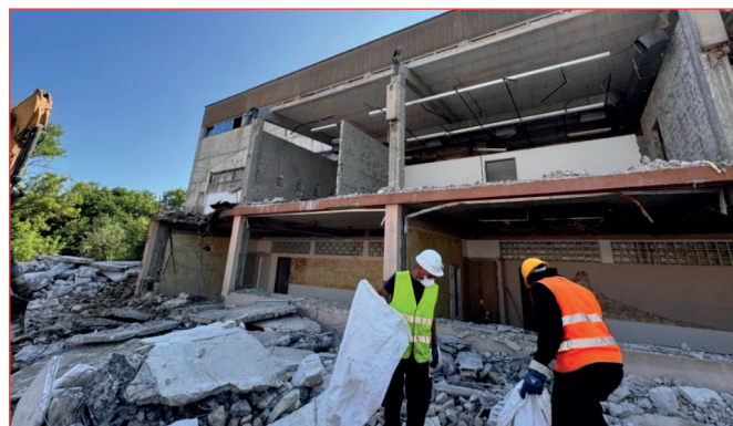
Démolition piscine (phase 2) à Steinfort
