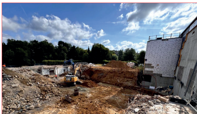
Démolition piscine (phase 2) à Steinfurt
