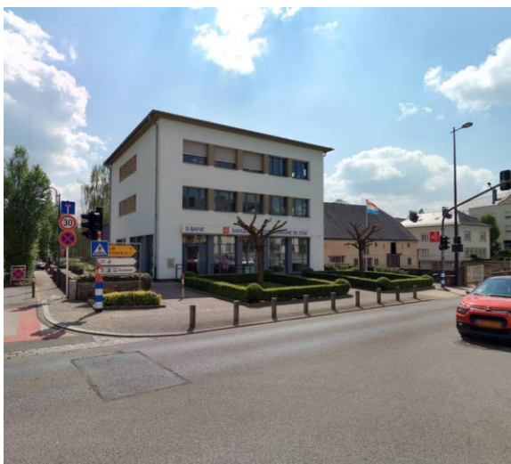
Banque (2, rue de Luxembourg)
