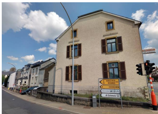
Rue de Hobscheid avec façade latérale de la maison 1, rue de Luxembourg
