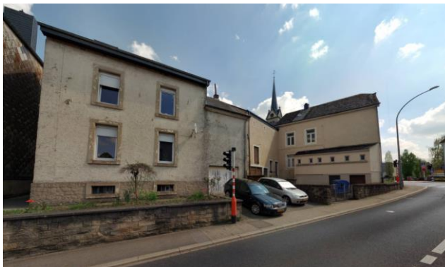
Maison unifamiliale avec grange accolée (2, rue de Hobscheid)
