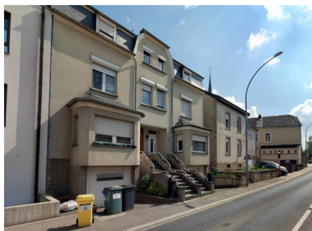
Maisons jumelées (4-6, rue de Hobscheid)
