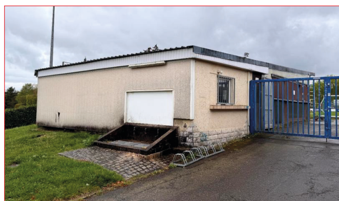
Démolition ancienne buvette
