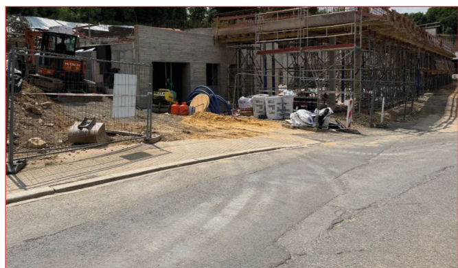
Travaux pour nouveau centre culturel à Steinfurt
