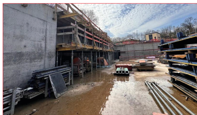
Travaux pour nouveau centre culturel à Steinfert
