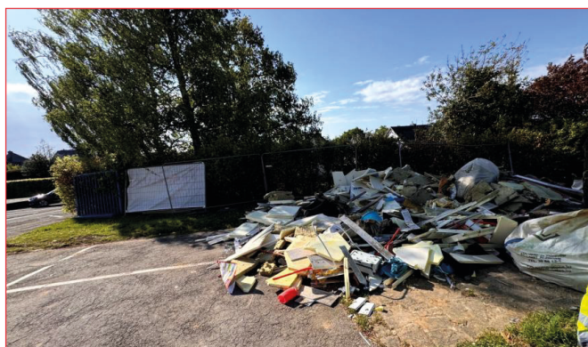
Démolition ancienne buvette
