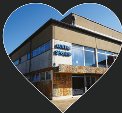
Centre Sportif Sportshal (7A, rue de Hagen)
