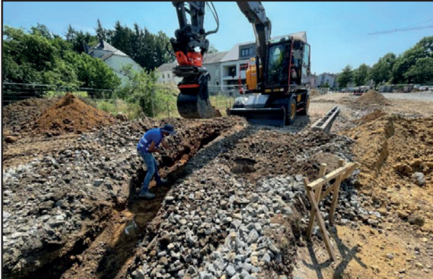
5 DÉVIATION DE LA CONDUITE D'EAU EXISTANTE
