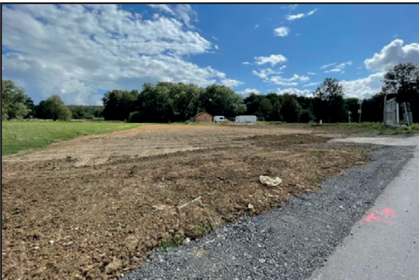
8 AMÉNAGEMENT EXTÉRIEUR EN COURS
