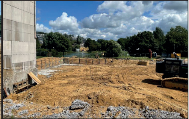
TRAVAUX DE TERRASSEMENT ET DE BLINDAGE (BERLINER VERBAU)
