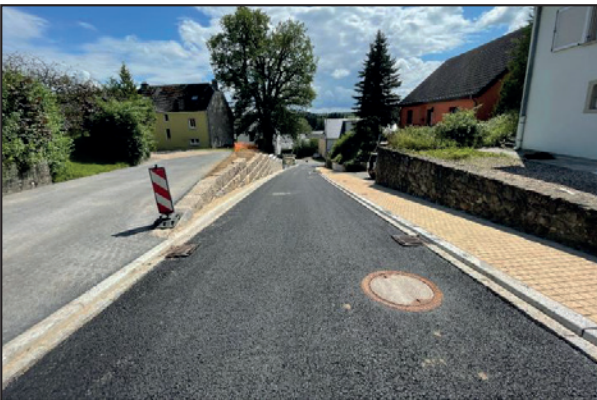
6 COUCHE BITUMINEUSE (BINDER 0/16) RÉALISÉE
