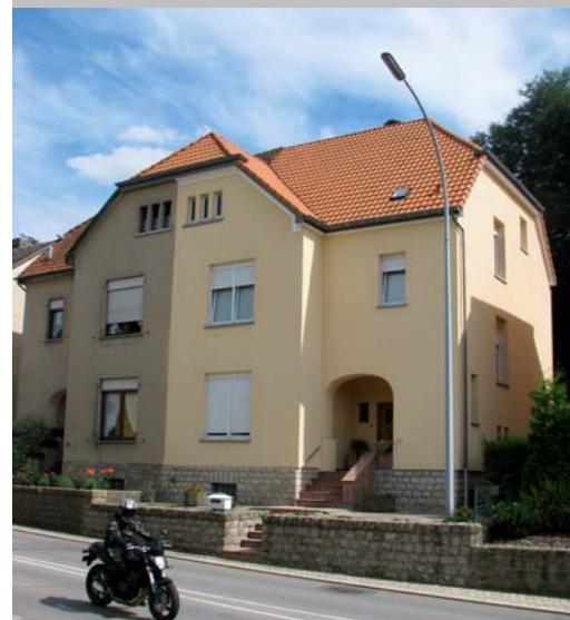
10 Zusammenhängende Baukörper sollten in einheitlicher Farbe und Dachdeckung gestaltet werden.
