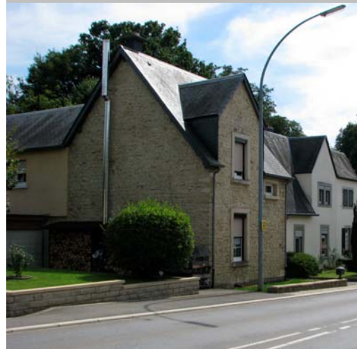
4 Neben verputzten Gebäuden finden sich in der Hobscheider Straße auch Fassaden aus Naturstein.
