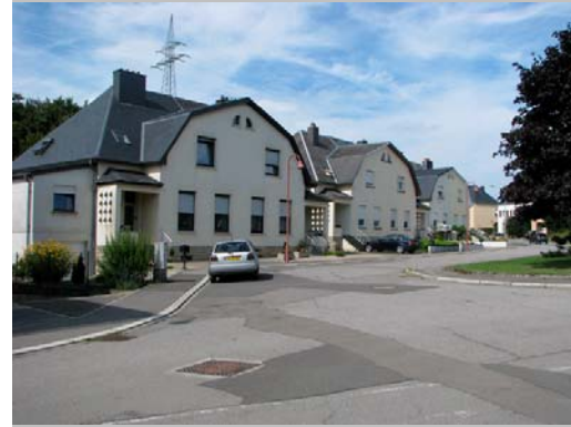
4 Anbauten und nachträglich überbaute Eingangspodeste stören die variantenreiche Anordnung der Gebäude.
