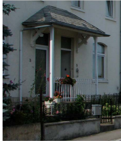
12 Die überdachten Eingangspodeste sind ein Gestaltungsmerkmal in der Cité Manzendorf
