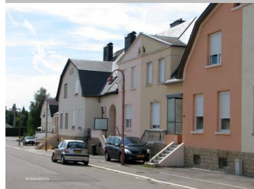
2 Cité Usine: Der Wechsel von giebel- & traufständigen Baukörpern verhindert Monotonie
