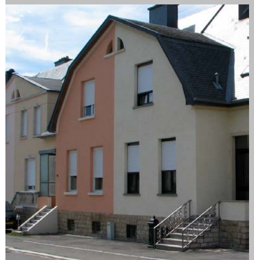
6 Starke Farbkontraste sollten vermieden werden um eine einheitliche Wirkung zu erzielen. Die originalen Natursteinsockel sollen erhalten bleiben und nicht durch Verkleidungen oder Mauerwerkssimulationen verdeckt werden
