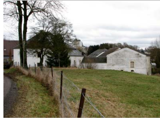
1 Die Alte Mühle prägt das Bild des Ortseingangs aus Richtung Sterpenich kommend.
