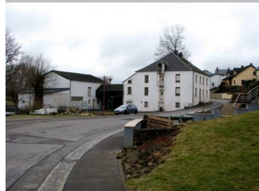
5 Durch ihre Dimensionen und die offene Hofanlage ist die Alte Mühle ein wichtiger städtebaulicher Baustein des Ortsbildes.
