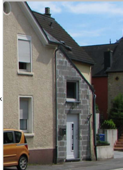
2 Unproportionierte und direkt an die Straßenfront „geklebte“ Anbauten wirken störend im Straßenbild.
