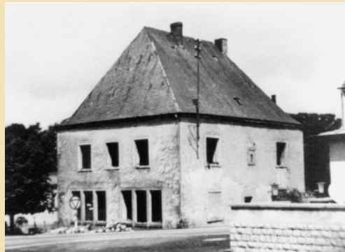
Standort der von der Festung Luxemburg nach Steinfort 1839 abkommandierten Brigade. Das Gebäude, das sich an der Stelle befand, wo heute der Parkplatz neben der Post ist, wurde 1960 abgerissen.
