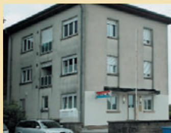
Das 1957 errichtete Polizeigebäude
