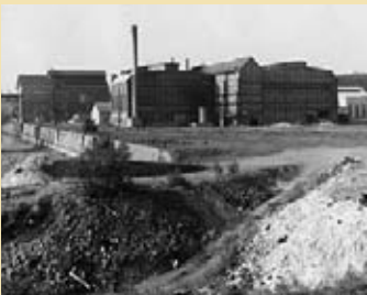
Das Phenolwerk kurz nach der Produktionseinstellung L'usine à phénol peu après l'arrêt de la production
