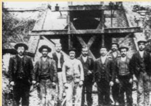
Der Bau der Attert-Linie - Arbeiter vor dem Eischener Tunnel La construction de la ligne de l'Attert - ouvriers du tunnel d'Eischen
