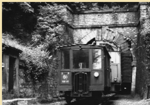
Ein Zug bei der Überprüfung des Tunnelprofils Un train lors de la vérification du profil du tunnel
