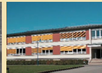
Die ehemalige Komplementärschule mit 6 Klassen L'ancienne école complémentaire et ses 6 classes
