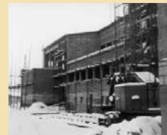
Die neue Schule in der Bauphase La nouvelle école en construction
