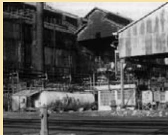
Teilansicht der Fusions- und Acidifikationshalle mit Natronlaugebehälter Vue partielle des ateliers de fusion et d'acidification, avec les réservoirs à soude caustique
