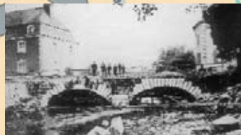
Renovierungsarbeiten 1927 Les travaux de rénovation en 1927
