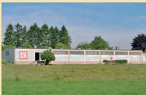
Blick auf die Fabrikationshalle Vue sur la halle de production
