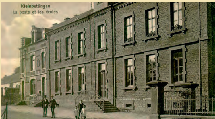
Post und Schule, neben dem Bahnhof die wichtigsten zentralen Einrichtungen. La Poste et l'école, à côté de la gare les aménagements centraux les plus importants.
