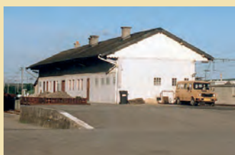
Lagerhalle am Bahnhof 1987 L'entrepôt près de la gare en 1987
