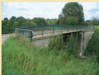
Die heutige Brücke ist Teil des Radwegs auf der ehemaligen Attert-Linie. Le pont est désormais une partie de la piste cyclable sur l'ancienne ligne de l'Attert.
