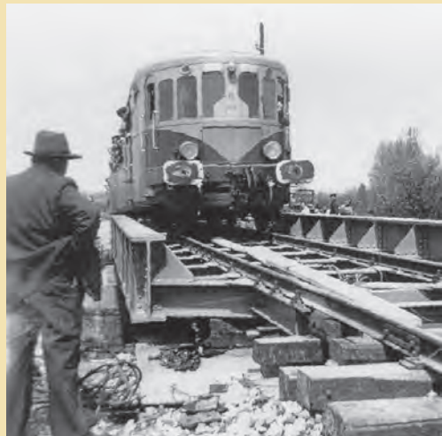
Ein Zug der Attert-Linie auf der Brücke Un train de la ligne de l'Attert sur le pont
